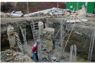
FONDACTIONS SUR PIEUX RÉALISATION IBATEC
